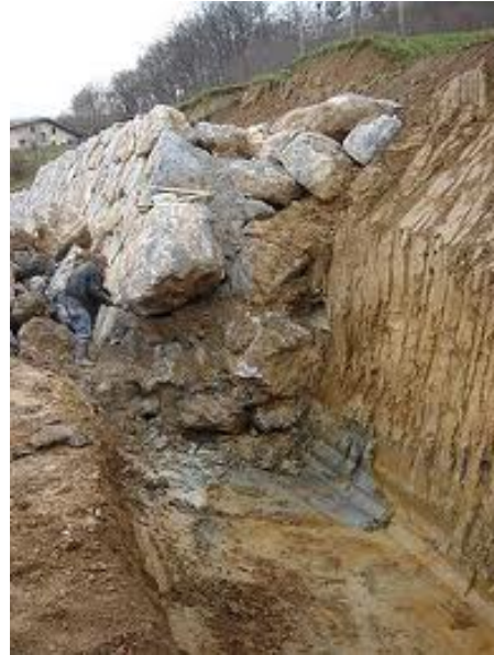
Estabilización de un talud con escollera
