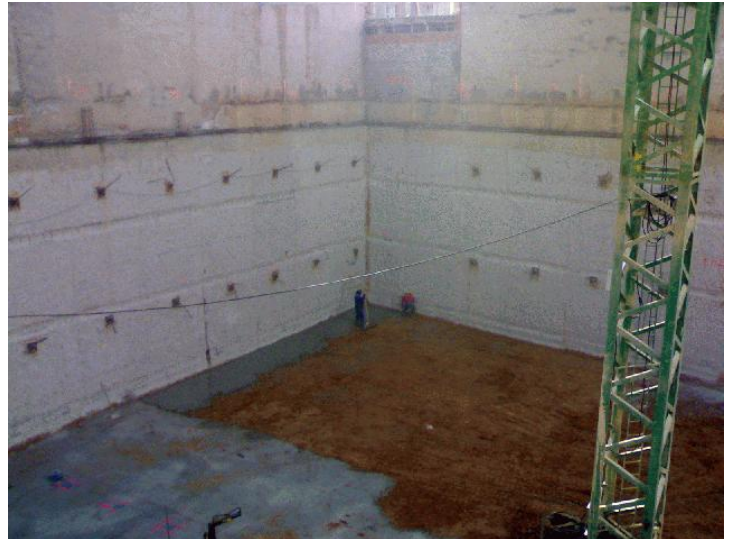
Recinto de pantallas con dos hileras de anclajes
