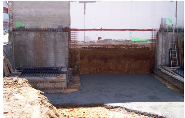
Construcción de muro de sótano por bataches.
