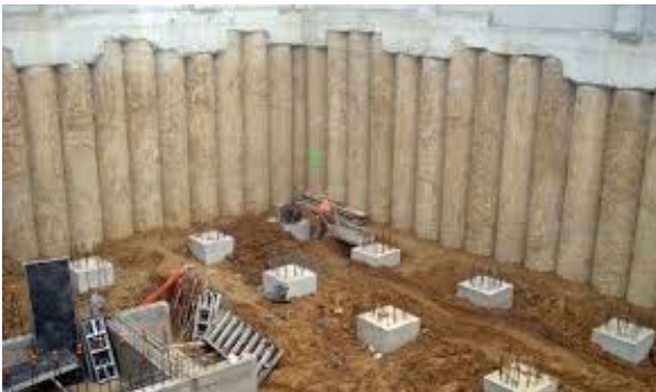
Pantalla de pilotes y viga de coronación
