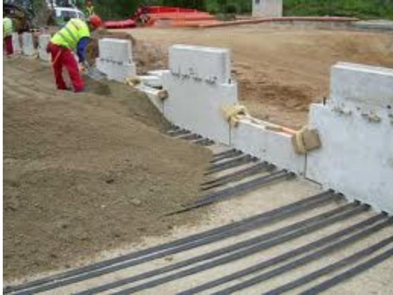
Flejes en placas de tierra armada
