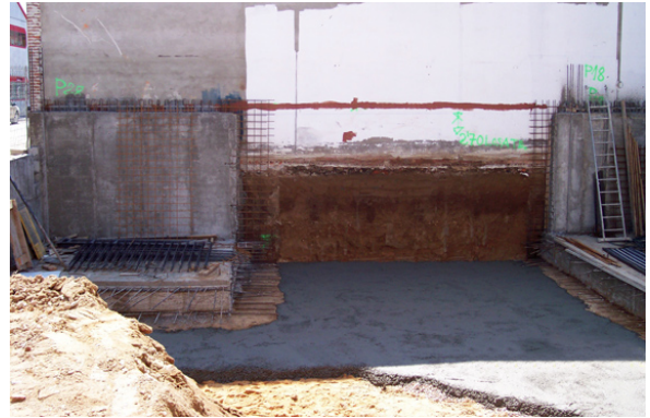
Construcción de muro de sótano por bataches.
