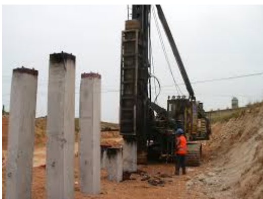
Máquina de hincado de pilotes de hormigón
