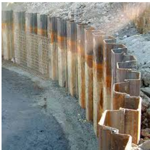
Muro de tablestacas
