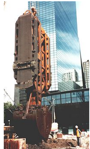
Detalle de cuchara de máquina pantalladora
