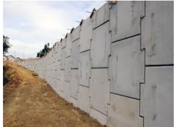
Acabado de muro de tierra armada
