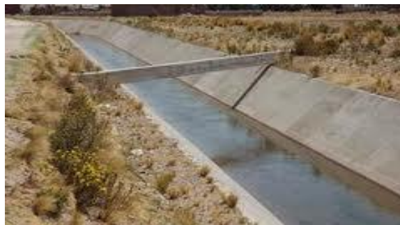
Canal revestido de sección trapecial
